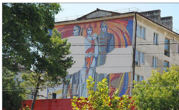
5. Разрушенная мозаика на улице Анапское шоссе
