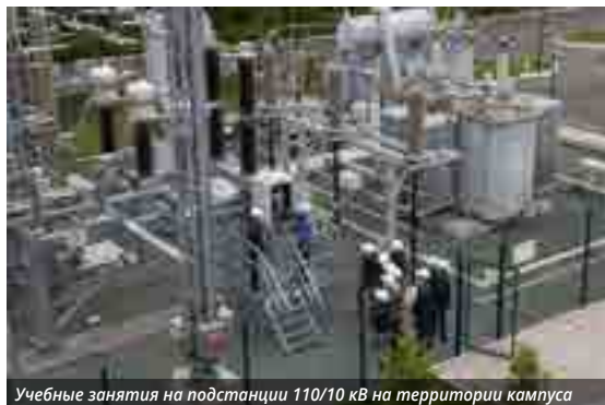
Учебные занятия на подстанции 110/10 кВ на территории кампуса
